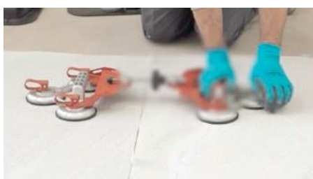
Speciální přísavkový uchopovač / Special device for the plate's pulling-over
